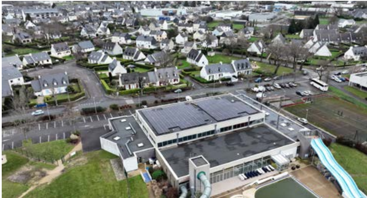
Grâce aux panneaux photovoltaïques installés sur le toit 10% de la consommation annuelle de Plijadour est désormais autoproduite. © ALECOB
