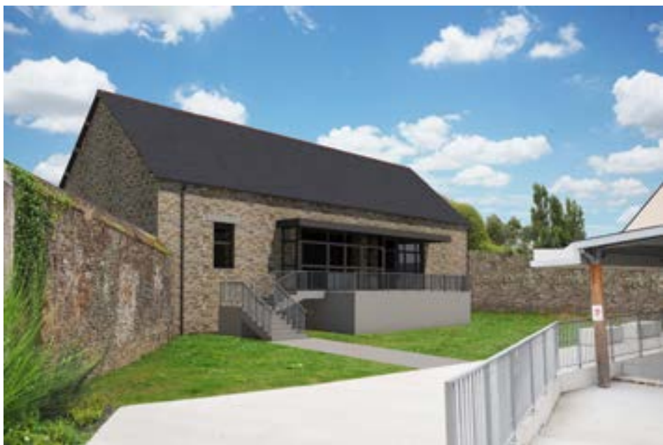
L'ancien entrepôt Le Manac'h a été réhabilité.
