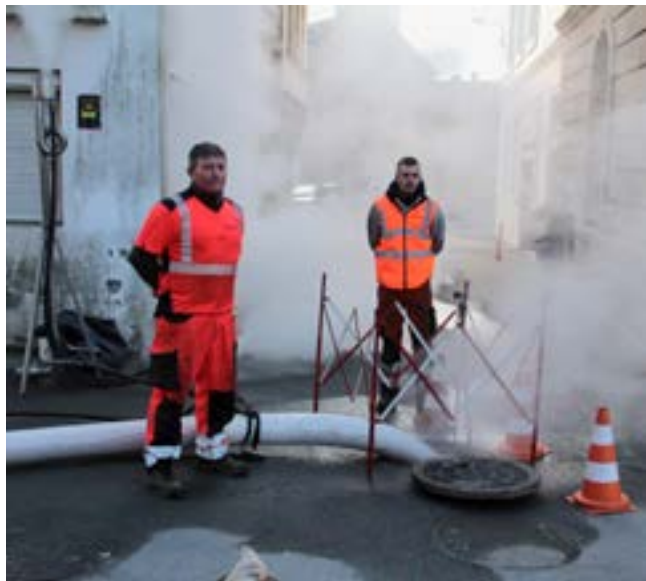
Les réseaux d'eaux ont été rénovés place de la Mairie avant le réaménagement de surface qui va commencer à la rentrée.
