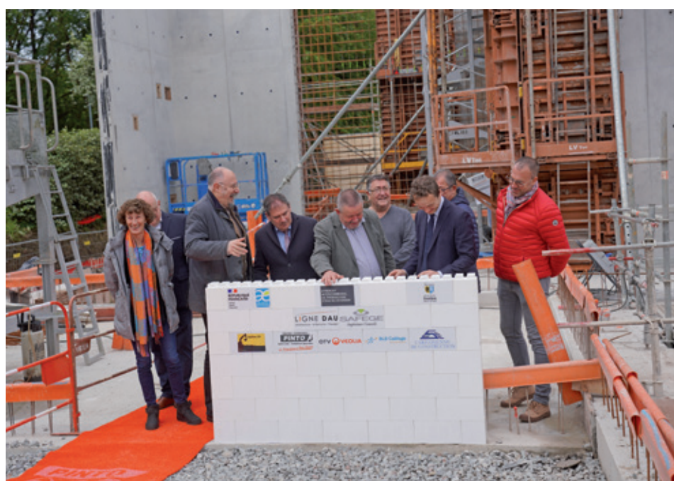
Pose de la 1 re pierre des nouveaux ouvrages de l'usine de production d'eau du Stanger Lakaat maen 1añ ar savadurioù nevez da zont e labouradeg produiñ dour ar Stangier
