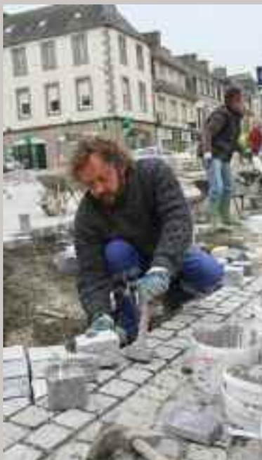
Morbihan, poursuivent la pose des pavés dans la deuxième moitié du carrefour. Il s'agit d'une pose en arceaux, pour une belle esthétique et une meilleure tenue. Les travaux devraient se terminer fin avril.
