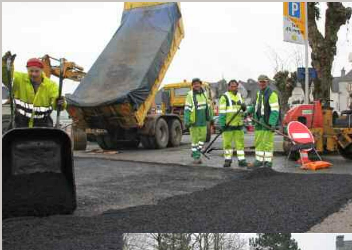
Courant mars, les services techniques de Poher communauté, missionnés par la Ville, ont effectué des travaux de réfection de la chaussée, place de la Tour-d'Auvergne, en remplaçant de larges bandes de bitumes dégradés. Ces mêmes services sont également intervenus pendant les vacances de février, pour l'aménagement de la cour de l'école de Kerven.
