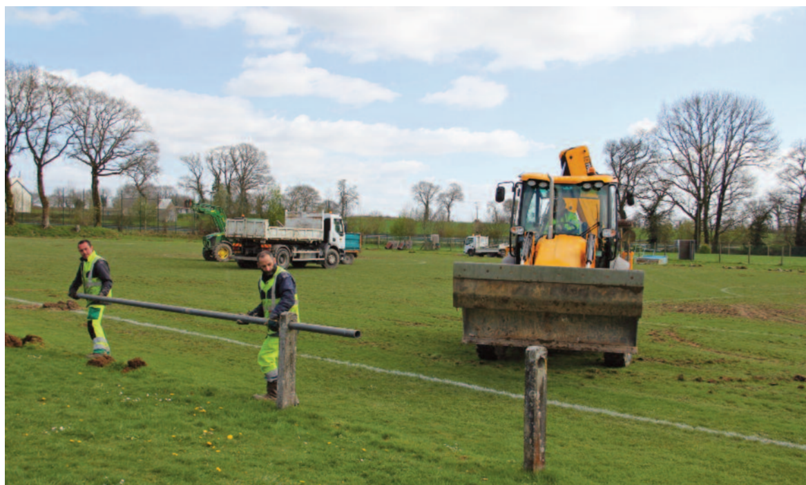
Fin mars, les services techniques de la Ville ont déposé les vieilles mains courantes du terrain de football de Poulriou.
