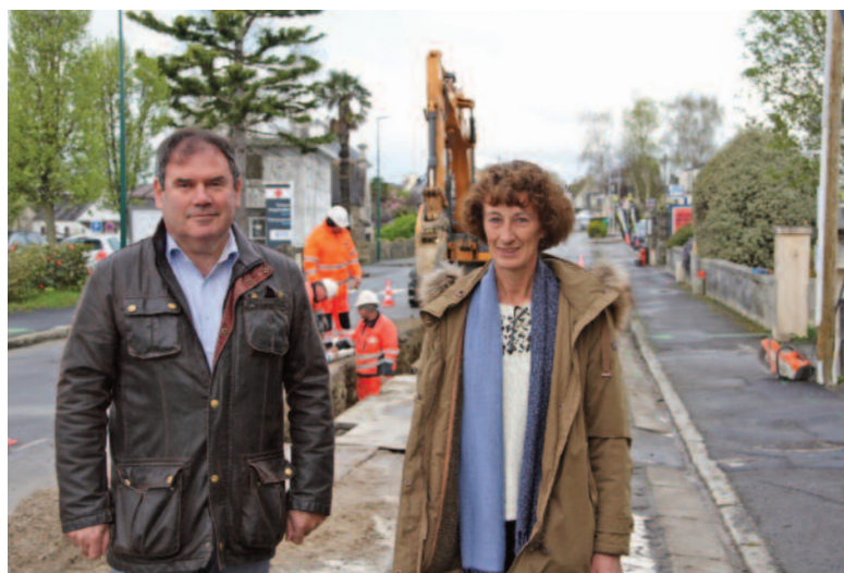
Christian Troadec, le Maire, et Jacqueline Mazéas, adjointe aux travaux et à la transition énergétique, rue du Docteur Menguy.
