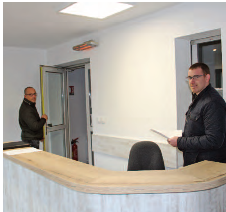
D'importants travaux de rénovation de l'intérieur de la Maison de santé, rue de l'Aqueduc Romain, viennent d'être réceptionnés par Poher communauté. Changement d'accueil, réfection des peintures, des sols... Thibaud Colliou (à droite sur la photo), chargé de projets à Poher communauté, a supervisé l'ensemble.
