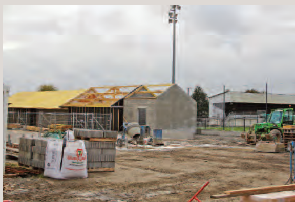
La construction d'un nouveau club-house est en cours dans la cour du Boulevard de la République. Le Cinédix est en plein travaux de réaménagement.
