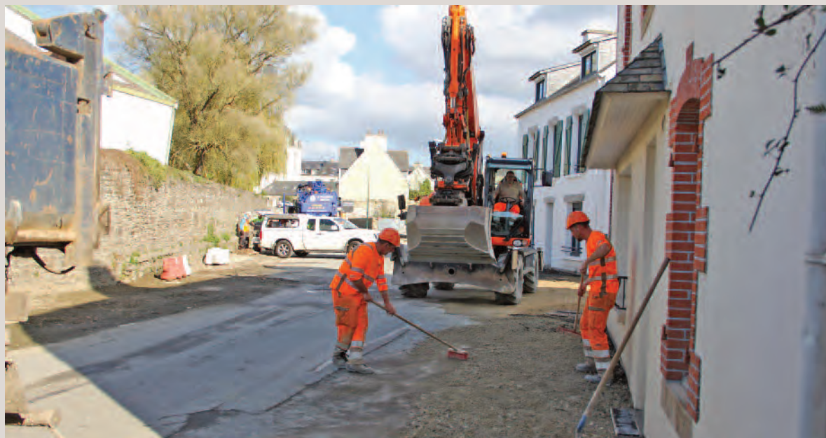
La première phase des travaux de réaménagement de la rue du Docteur Menguy, entre le rond-point du Boulevard et la rue des Clochettes, sera rendue à la circulation pour le 20 décembre.
