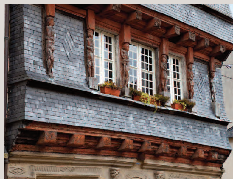
Les façades de la Maison du Sénéchal vont être rénovées.
