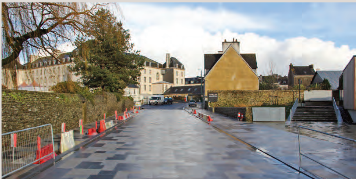
Travaux d'aménagement de la rue du Docteur Menguy.
