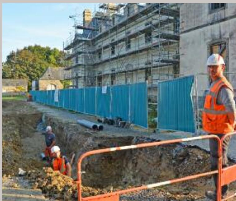
La Ville de Carhaix a fait réaliser d'importants travaux sur les réseaux à Kerampuilh. Des travaux sur le réseau d'assainissement ont été réalisés le long de la rue J.-S.- Corvellec, puis les réseaux ont été repris le long de l'étang, en remontant sous la piscine et la maison de
